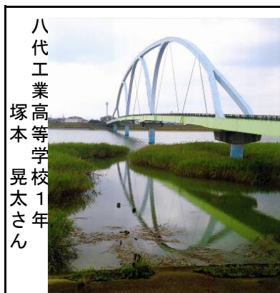
〔銀賞〕金剛歩道橋
