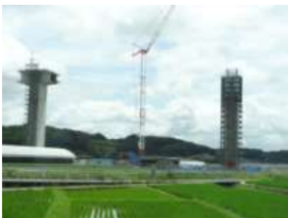
熊本西環状道路橋りょう工事
