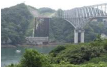
熊本天草幹線道路新天門橋工事
