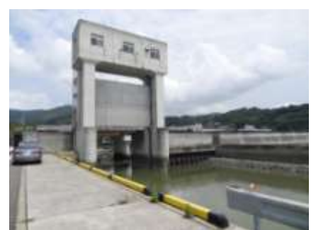
松合地区防災工事
