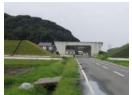
熊本宇土道路工事
