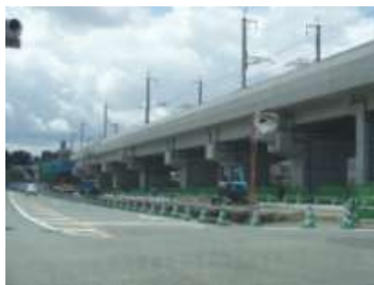
鉄道高架工事
