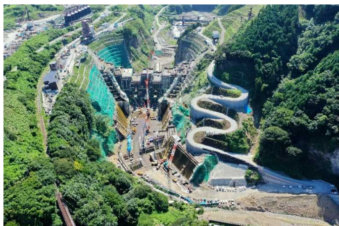
立野ダム建設工事
