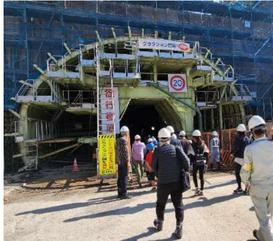
滝室坂トンネル
